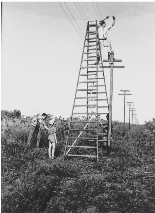
Radiotelescopio interferométrico constituido por 16 antenas tipo yagi ubicado en el Aeropuerto Nacional de Carrasco. Se lo utilizó para estudiar radioexplosiones solares, en particular las Tipo IV (ca. 1965).
