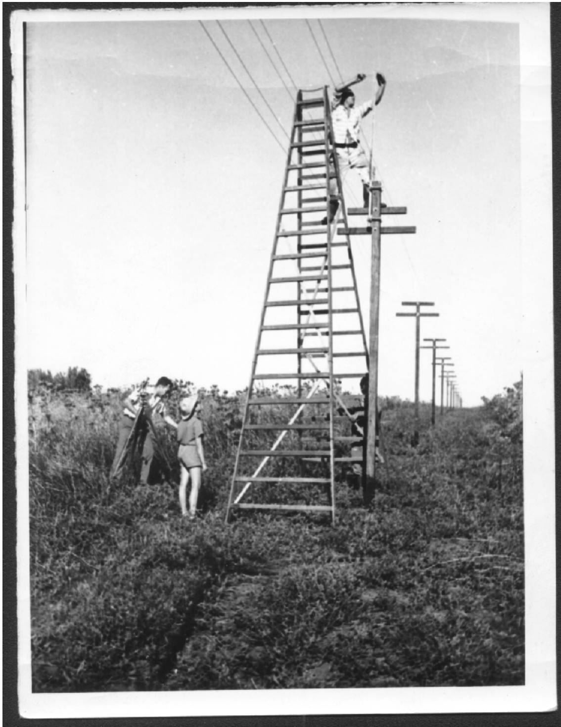
En esta imagen se aprecia a Julio Fernández subido a una escalera trabajando con una de las 16 antenas que conformaban el radiointerferómetro de Carrasco. (gentileza de Julio Fernández).
