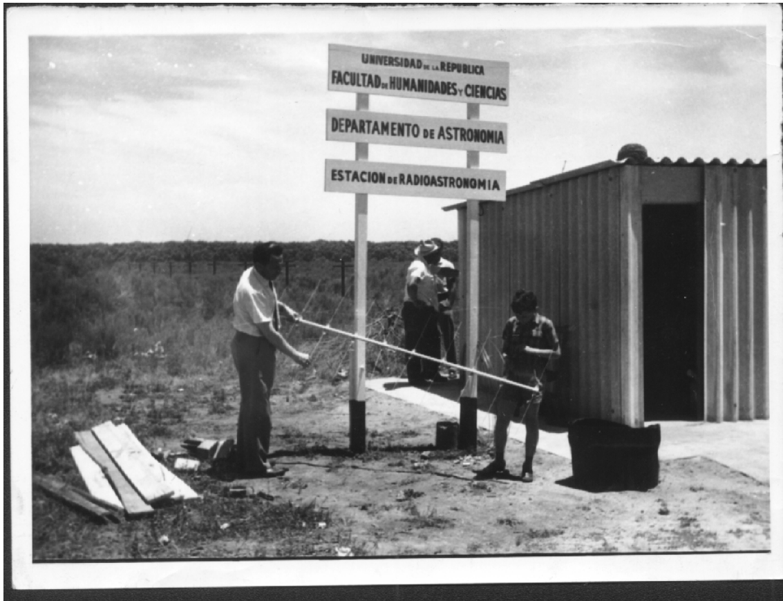
En la fotografía se aprecia al Dr. Cernuschi manipulando una de las antenas que conformaban el radiointerferómetro de Carrasco. La caseta albergaba el equipo receptor y de medición. (gentileza de Julio Fernández)
