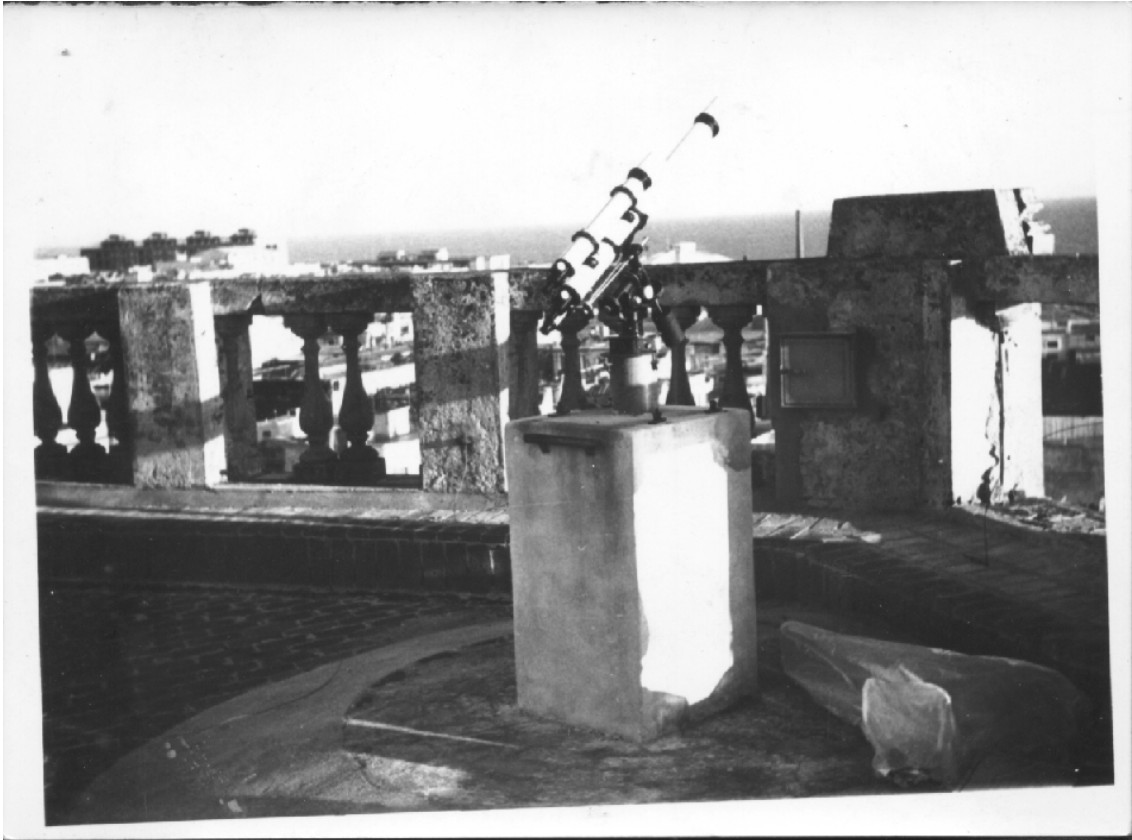
El refractor Unitron instalado en la azotea de la antigua FHC, ubicada en las calles Cerrito y Lindolfo Cuestas, cerca de la Aduana. (gentileza de Julio Fernández)
